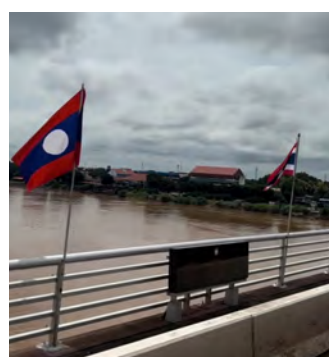
写真 3-③ 電車から見た 友好橋（タイとラオスの境）
