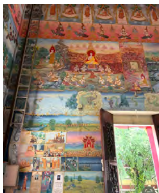
写真 3-⑤ 寺院内壁面
