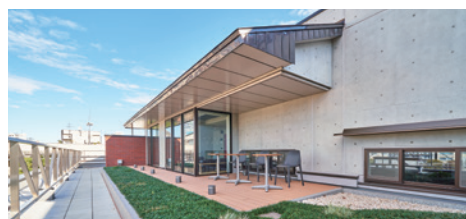
4階屋上デッキ
